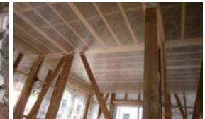
【断熱工事】快適性の重要な要素が断熱。外周に面する、床壁天井全てにセルロースファイバーを施工。
